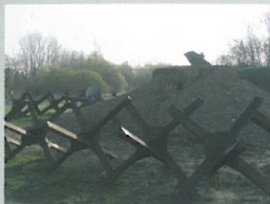
Lehké opevnění – vzor 36 s protitankovými zátarasy
