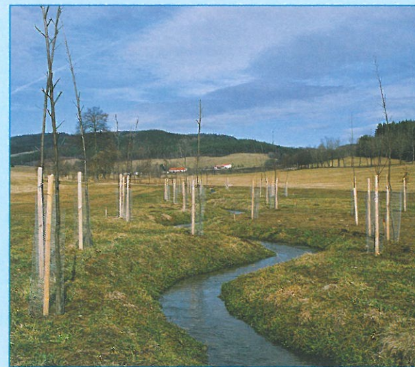
Doprovodná vegetace nejen zlepšuje biologickou hodnotu krajiny, ale zároveň slouží ke zpevnění konkávních břehů, které jsou nejvíce namáhány proudící vodou.
