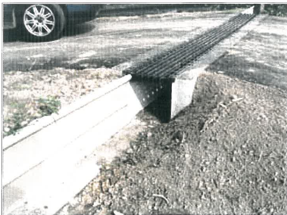
Obr. 18: Příklad podchodu pod silnicí (zdroj: ANONYM 2009).
