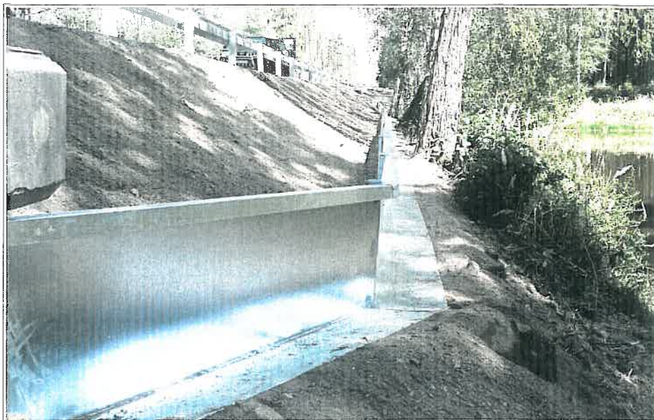
Obr. 17: Příklad trvalých zábran zhotovených ve svahu silnice (zdroj: SVOBODA & FRANCEK & ROZÍNEK 2014).
