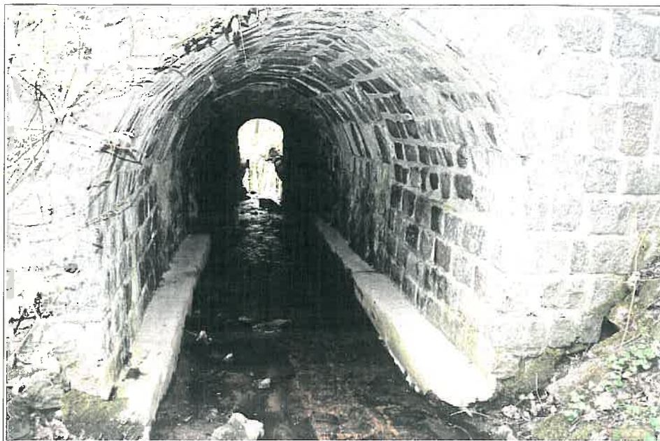
Obr. 19: Mostní propust' Kovářovského potoka pod silnicí.
